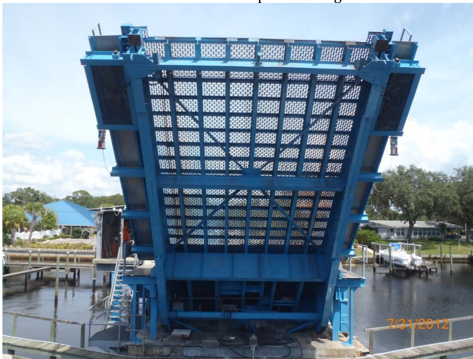
Photo A: Bascule Span Framing
