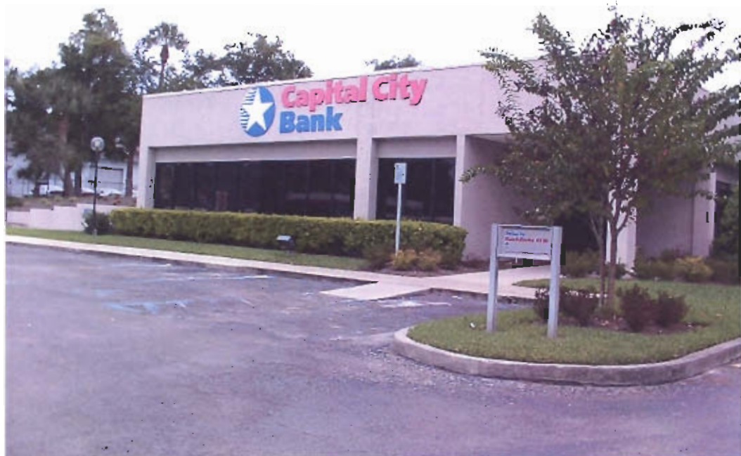
Site 67. Capital City Bank, 101 SE US 19.
